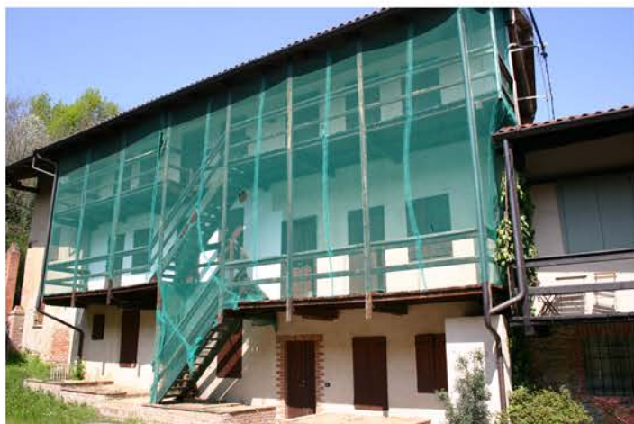
Immobile suddiviso in n.5 unità
